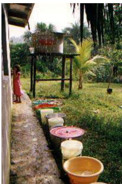
Figura II.1 Sistema de coleta de água da chuva. (foto: M.C. Fedrizzi, 1999)
