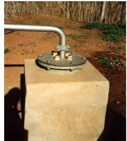
Figura 3.6 – Boca de poço tubular, lacrada, Projeto Eldorado, PE. (Foto: M.C. Fedrizzi, 1998)
