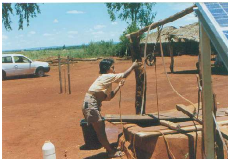
Figura 3.41 – Captação de água manual, subutilização do sistema e contaminação da água, MS. (Foto: M.C. Fedrizzi, 2000)
