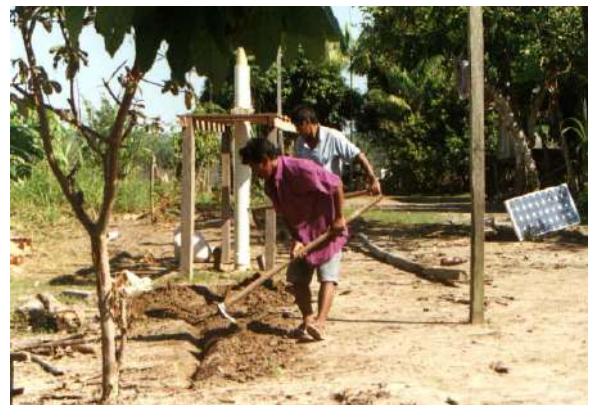
Figura II.8 Instalação da rede hidráulica. (foto: M.C. Fedrizzi, 1999)
