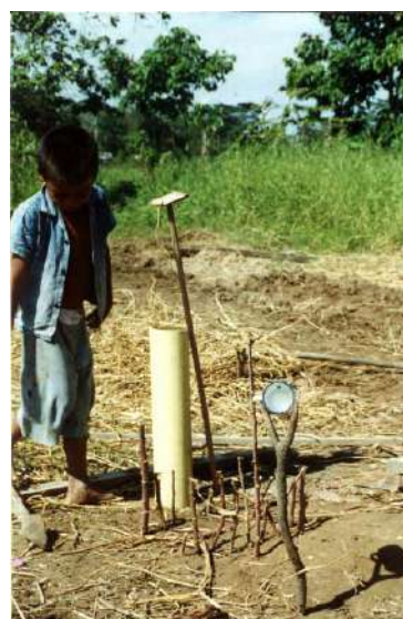
Figura II.12 Crianças construindo seu sistema de bombeamento fotovoltaico. (foto: M.C. Fedrizzi, 1999)
