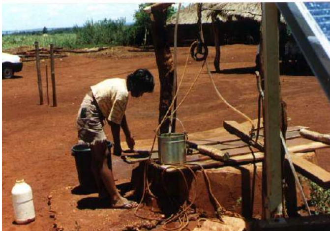
Figura 3.5 – Boca de poço tipo cacimba, sem proteção, PRODEEM, MS. (Foto: M.C. Fedrizzi, 2000)
