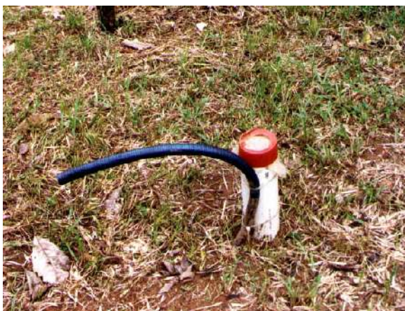
Figura 3.35 – Poço desativado. (Foto: M.C. Fedrizzi, 2000)
