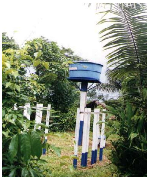
Figura 3.37 – Infra-estrutura abandonada: reservatório e suporte para gerador fotovoltaico. (Foto: M.C. Fedrizzi, 2000)
