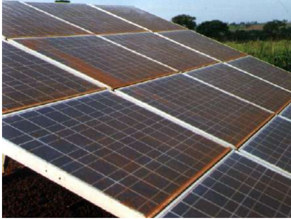
Figura 3.20 – Sombreamento de módulos fotovoltaicos por poeira, SP. (Foto: M.C. Fedrizzi, 2002)
