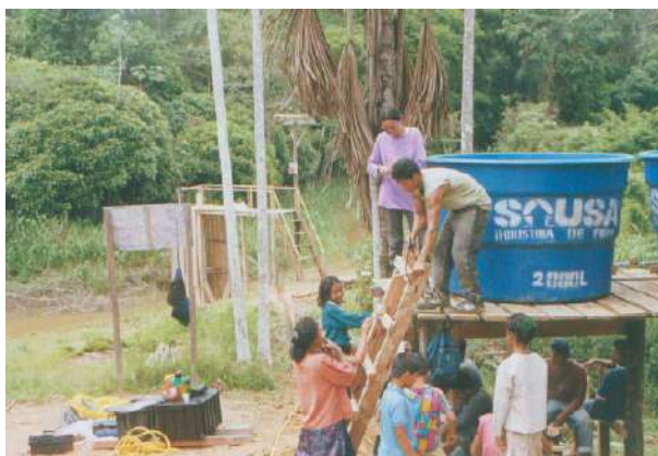
Figura II.9 Instalação da estrutura dos pontos de coleta de água. (foto: M.C. Fedrizzi, 1999)
