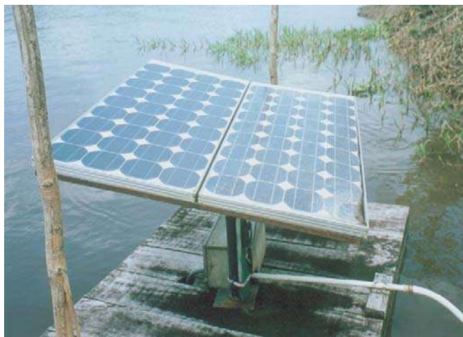
Figura 4.3 – Sistema de bombeamento fotovoltaico de superfície instalado em flutuante. (Foto: M.C. Fedrizzi, 2002)
