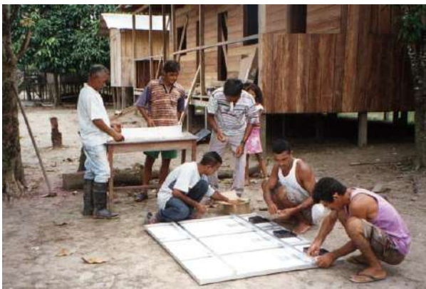
Figura II.7 Montagem da estrutura dos módulos fotovoltaicos. (foto: M.C. Fedrizzi, 1999)
