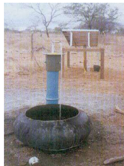
Figura 3.40 – Ausência de infra-estrutura de reservatório. (Fonte: COSTA & ARAÚJO, 2001)
