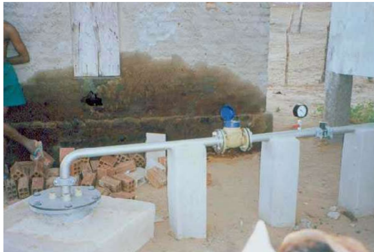
Figura 2.9 – Boca do poço de um sistema do Projeto Eldorado em Inajá, PE. (Foto: M.C. Fedrizzi, 1998)
