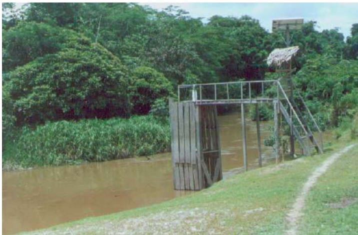
Figura 4.4 – Sistema de bombeamento na várzea, em terreno com baixa permeabilidade, em época de estiagem. (Foto: M.C. Fedrizzi, 2002)
