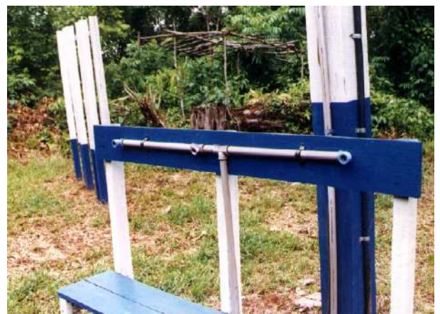
Figura 3.36 – Estrutura de ponto de coleta de água abandonada. (Foto: M.C. Fedrizzi, 2000)
