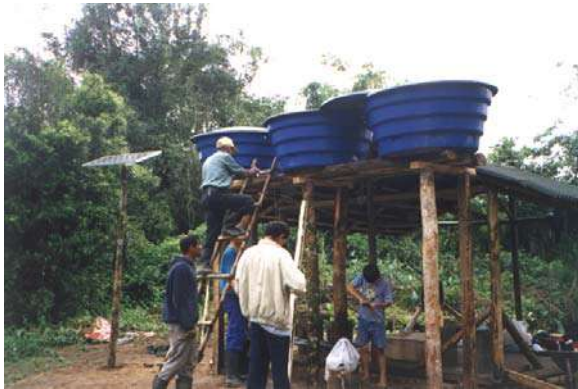
Figura I.14 Instalação dos reservatórios. (Foto: M.C. Fedrizzi, 1998)
