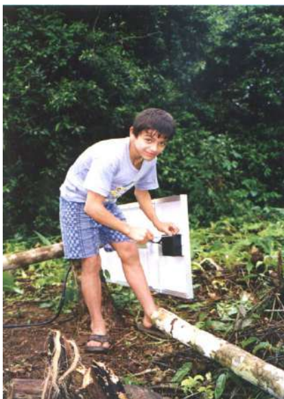
Figura I.16 Instalação dos módulos fotovoltaicos. (Foto: M.C. Fedrizzi, 1998)
