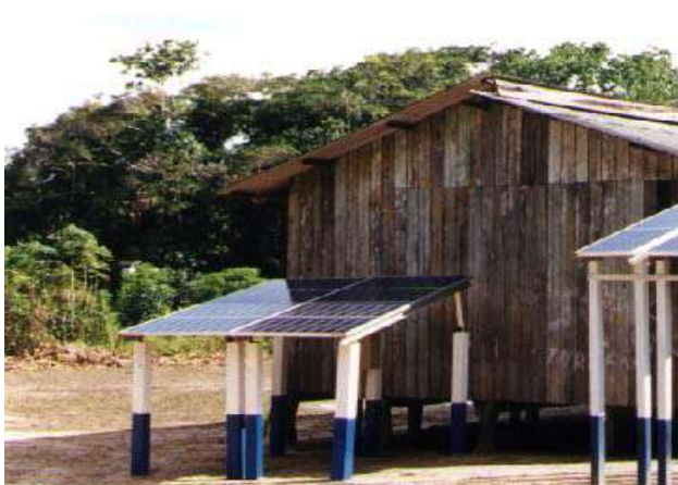
Figura 3.18 – Sombreamento de módulos fotovoltaicos por construção contígua, RO. (Foto: M.C. Fedrizzi, 2000)
