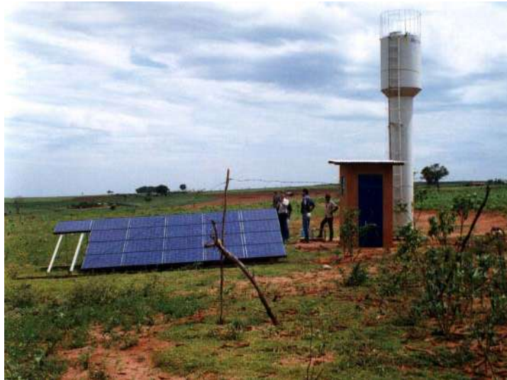
Figura 4.2 – Sistema de bombeamento fotovoltaico em poço tubular, terra firme. (Foto: M.C. Fedrizzi, 1999)
