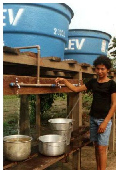
Figura 3.30 – Torneiras bem fixadas, em comunidade ribeirinha, AM. (Foto: M.C. Fedrizzi, 2002)
