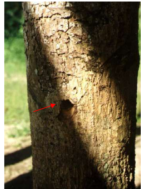
Figura 3.32 – Madeira de suporte dos reservatórios perfurada por coleópteros, SP. (Foto: M.C. Fedrizzi, 2002)
